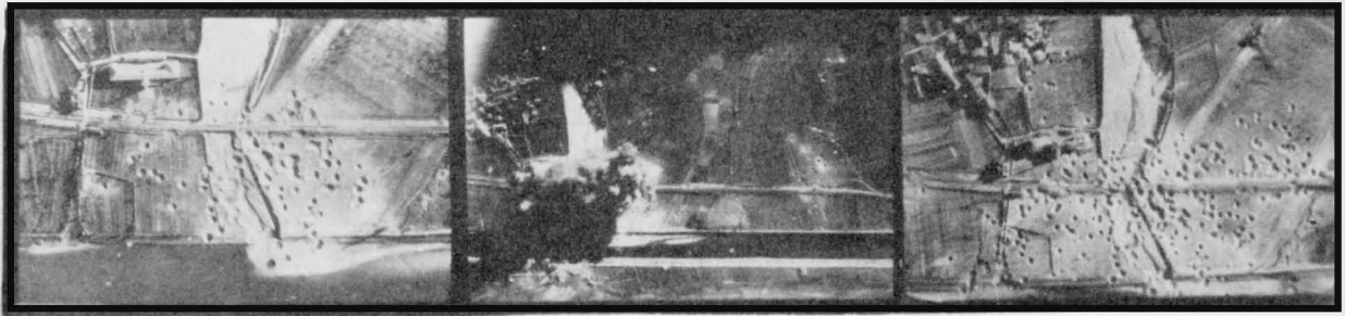
CALLIANO R. R. BRIDGE
